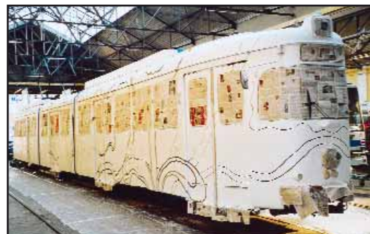
In nur sechs Wochen entstand das Kleid der Straßenbahn im Betriebshof der HSB
